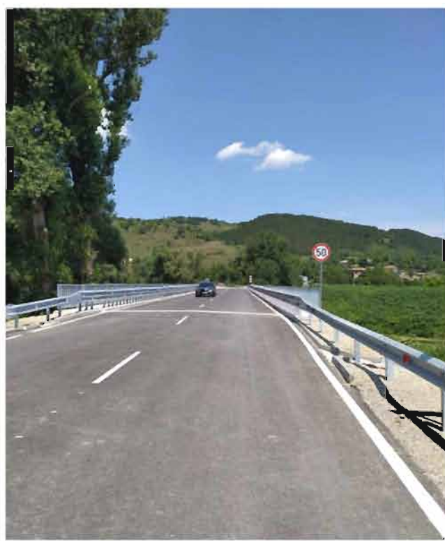
Стоманобетоненият мост над р. Белица при гр. Дебелец
