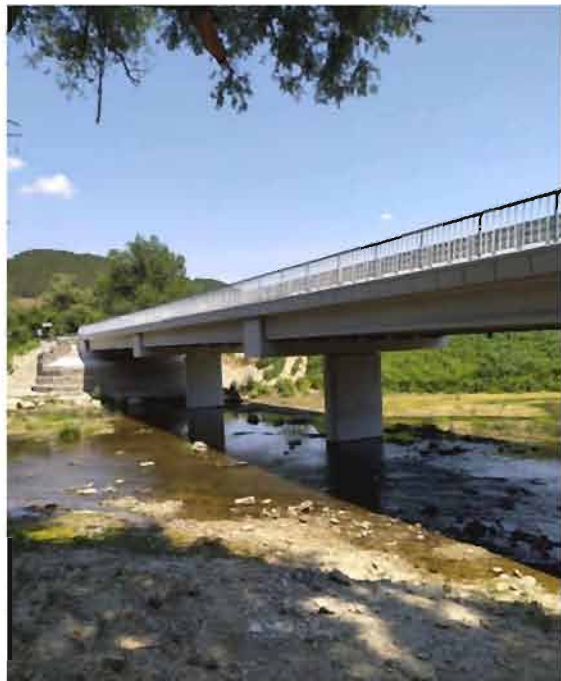
Стоманобетоновият мост над р. Белица при гр. Дебелец
