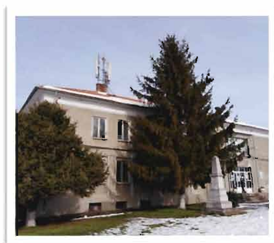
Ремонт на читалището в с. Беляковец
