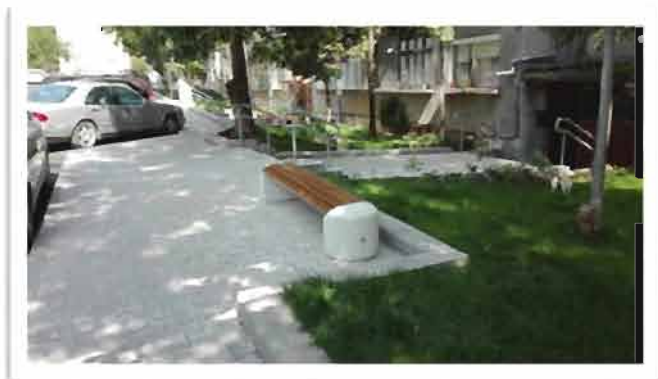
Ремонтирани тротоари и реконструирани подходи към жилищни сгради в кв. „Чолаковци“
