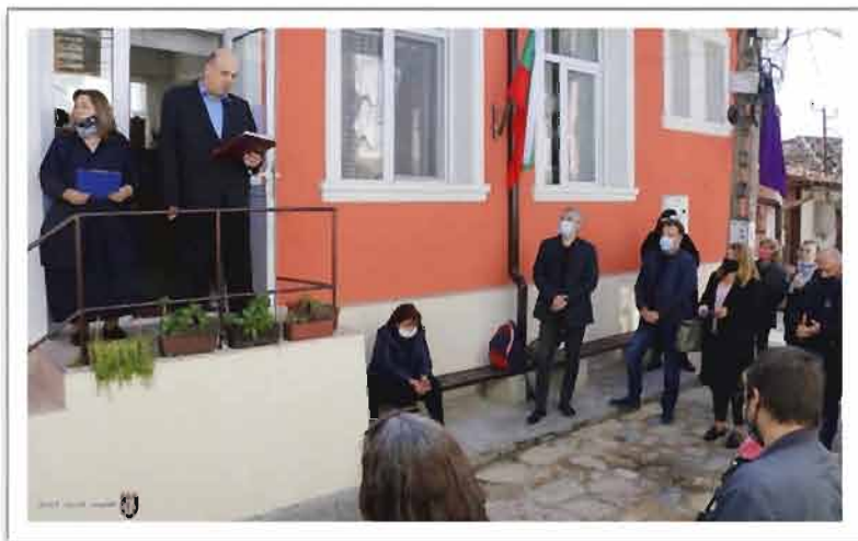
Ремонтирано НЧ „П. Р. Славейков“, кв. „Варуша“
