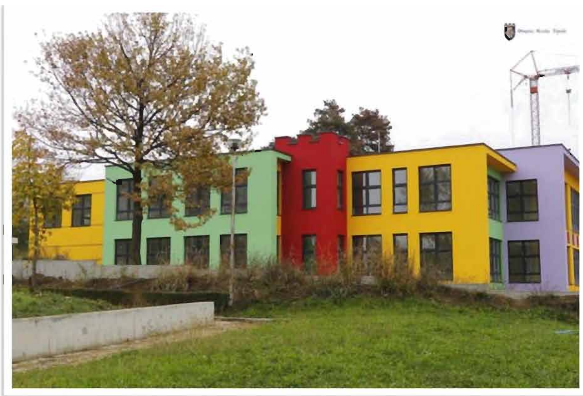
Изграждане на ДГ „Шареният замък“
