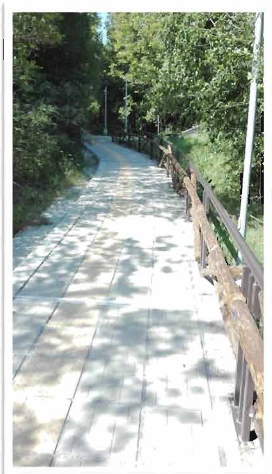
Изградена пешеходна алея, свързваща кв. "Чолаковци" и кв. "Бузлуджа"
