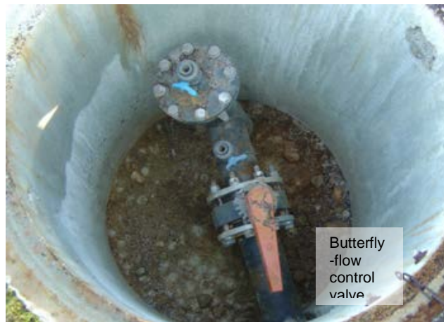
Фигура VI-11 Типичен газоотвеждащ кладенец за сметищен газ
