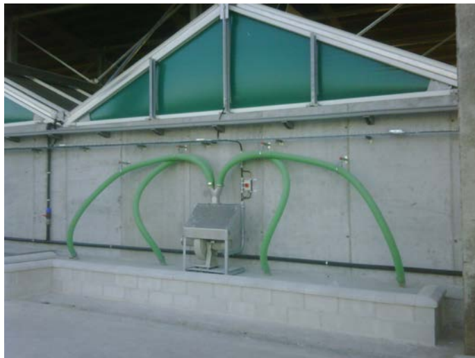
Фигура VI-31 Система за аерация на тунел с автоматична покривна конструкция
